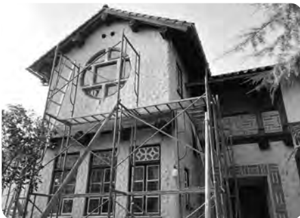
猛暑の中、外回り、下水工事他、家の中も着々と修理が進められています! 貴重な窓ガラス。修復も丁寧に、
